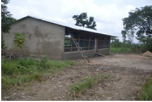
PHOTO 2 : les bâtiments d'élevage presque achevés à la ferme
